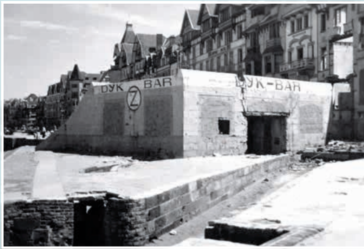
Als 'dijk-bar' gecamoufleerde bunker met het logo van Compagnie Het Zoute (zie foto 6 I7), op de zeedijk van Knokke, 1945.
