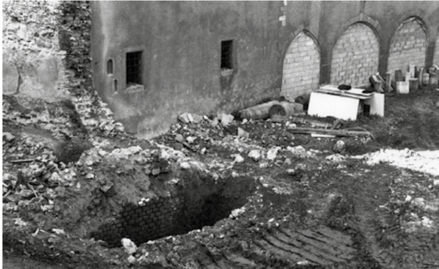
Fig. 19 – Murs antiques découverts dans la cour de Chèvremont (pièce XXVII) lors des travaux d'extensions du musée en 1976 (musée de La Cour d'Or-Eurométropole de Metz).
