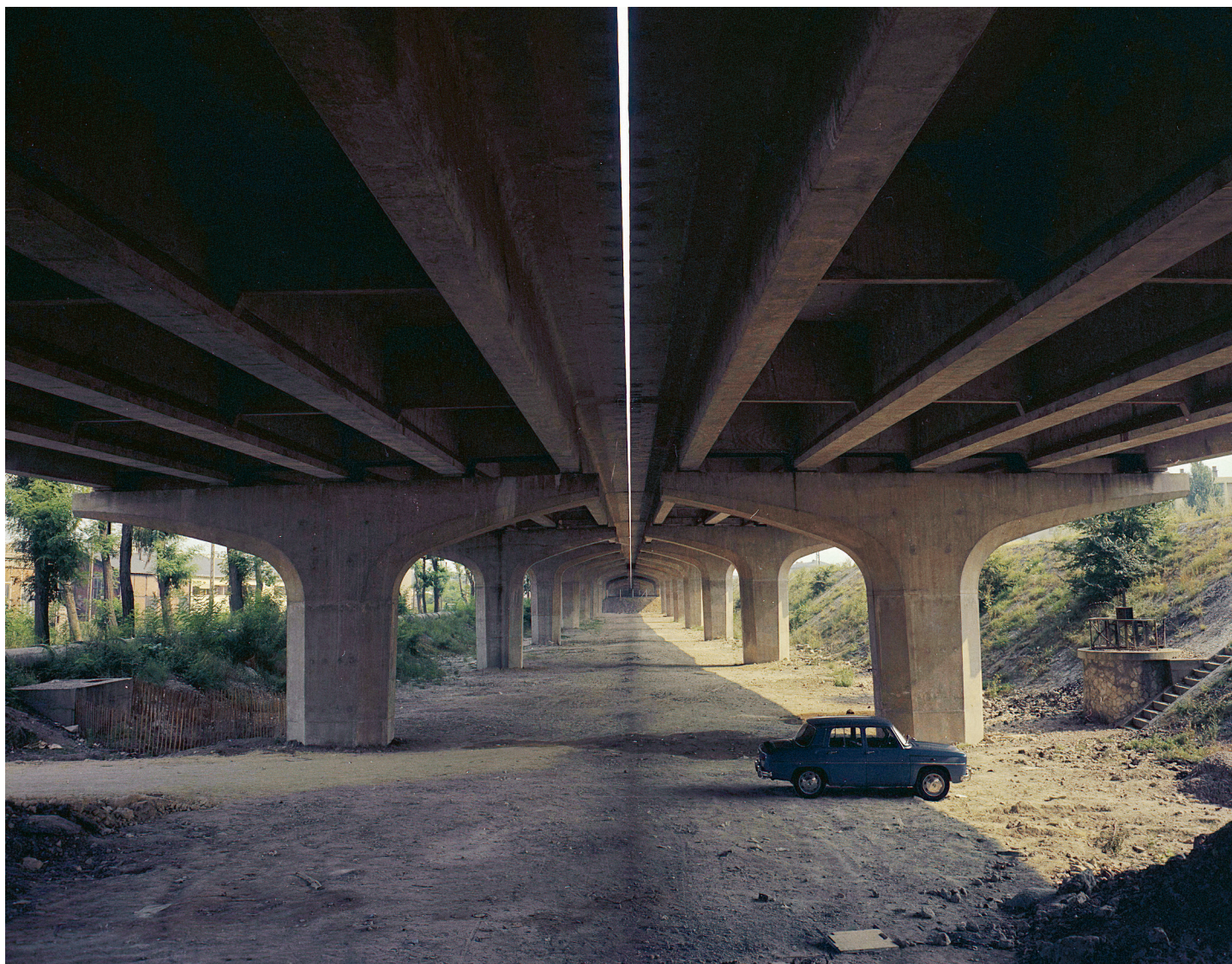
↑ Les piles du viaduc de l'autoroute A10 (1967) sont fondées dans le lit de l'ancien canal de Berry. AD IL, 5Fi015439.
