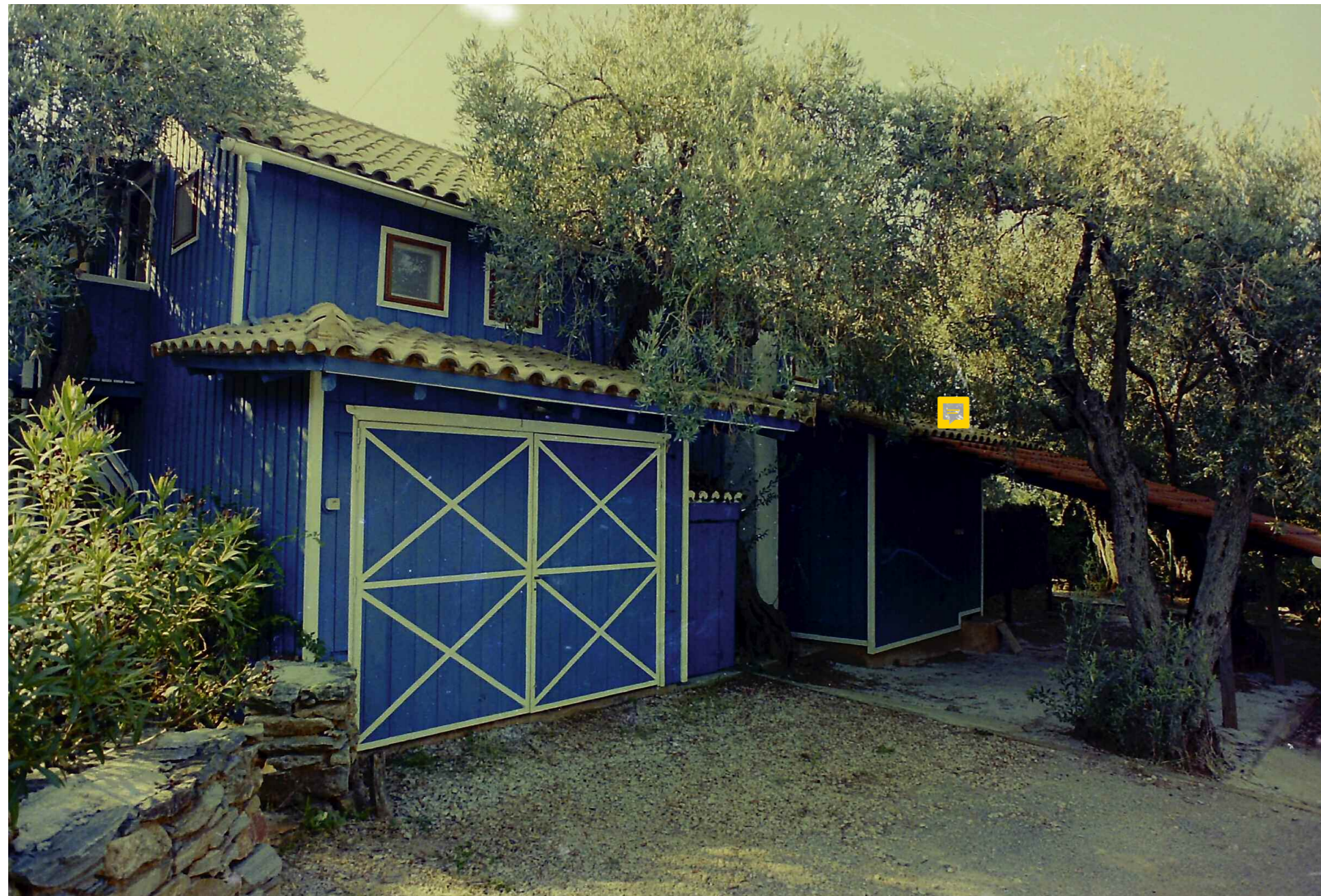
Structure légère de bois inspirée par les hangars de l'île de Skopelos. Le bâtiment abrite un salon au rez-de-chaussée et des chambres à l'étage.
