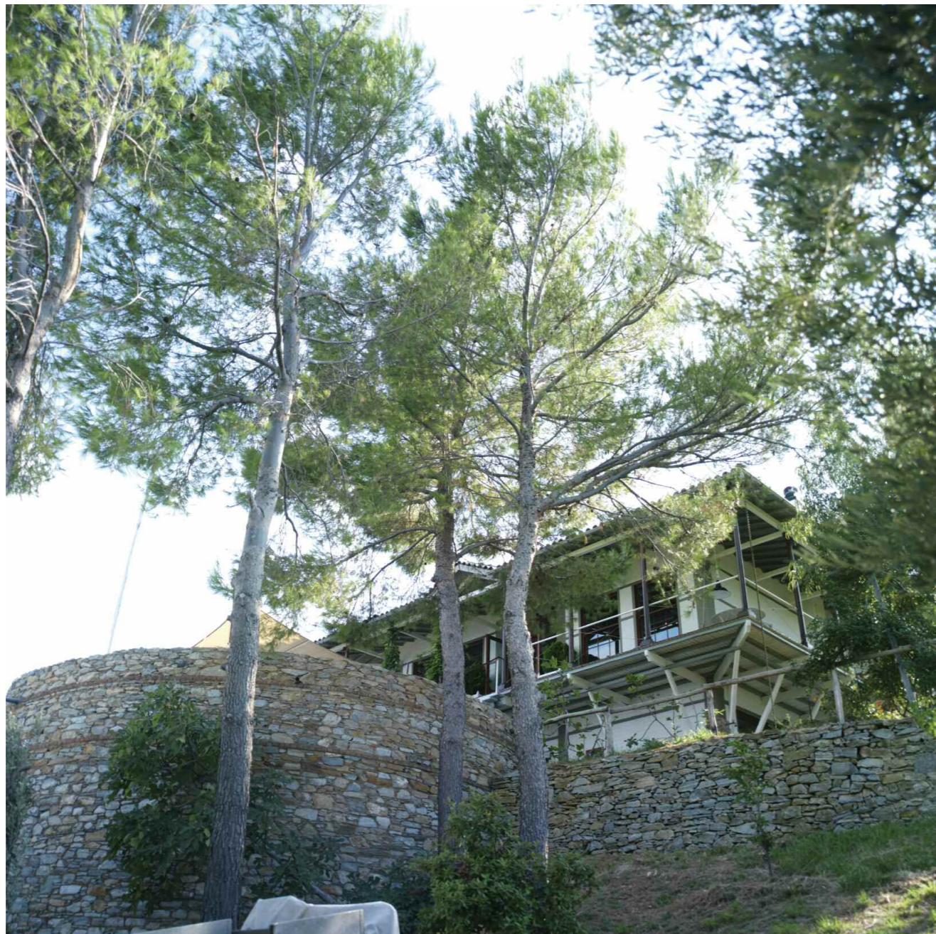
Grand cylindre de pierre, citerne de récupération des eaux pluviales. Large stone cylinder, rainwater recovery tank.
