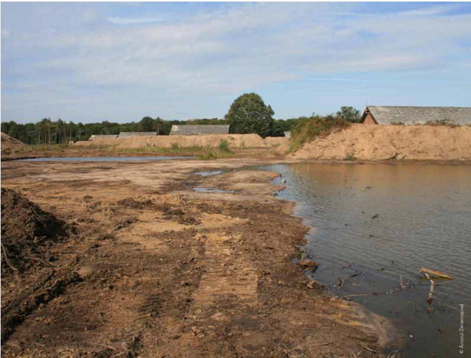
In 2008 werden grote terreingedeelten geplagd, waaronder ook de oevers van deze venachtige plas. De taluds werden van struweel ontdaan en opnieuw geprofileerd. Alleen de resterende heide werd gespaard. In de jaren nadien ontwikkelde zich hier opnieuw een paars tapijt van drie verschillende heidesoorten.
