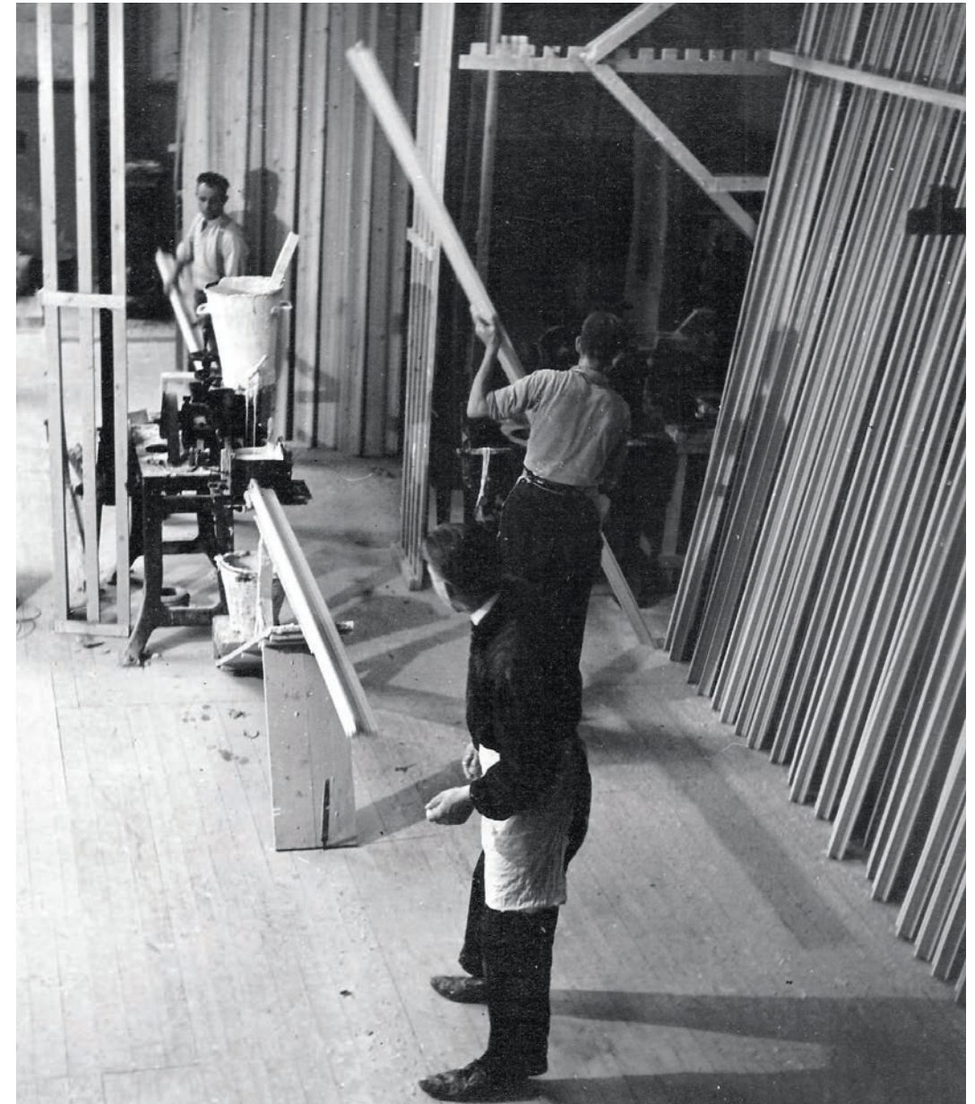
2.1 Krijtgrondering wordt machinaal op een lijstprofiel aangebracht bij de firma A.J. Heijdenrijk jr., Amsterdam, ca. 1920-1930
