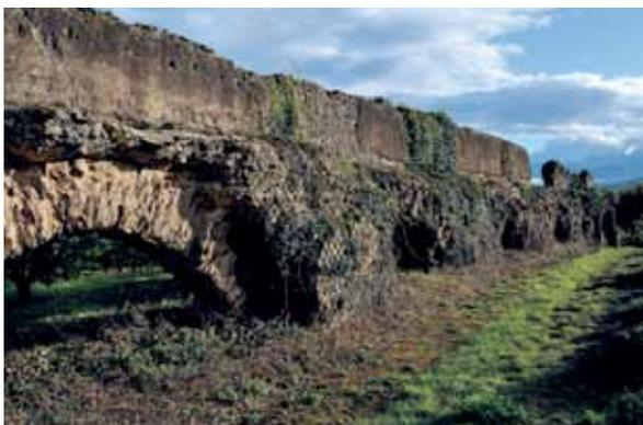
Sur les arches de la Gerle, à Soucieux-en-Jarrest (Rhône), il reste une des parois du canal encore recouverte de son enduit de mortier rose.
