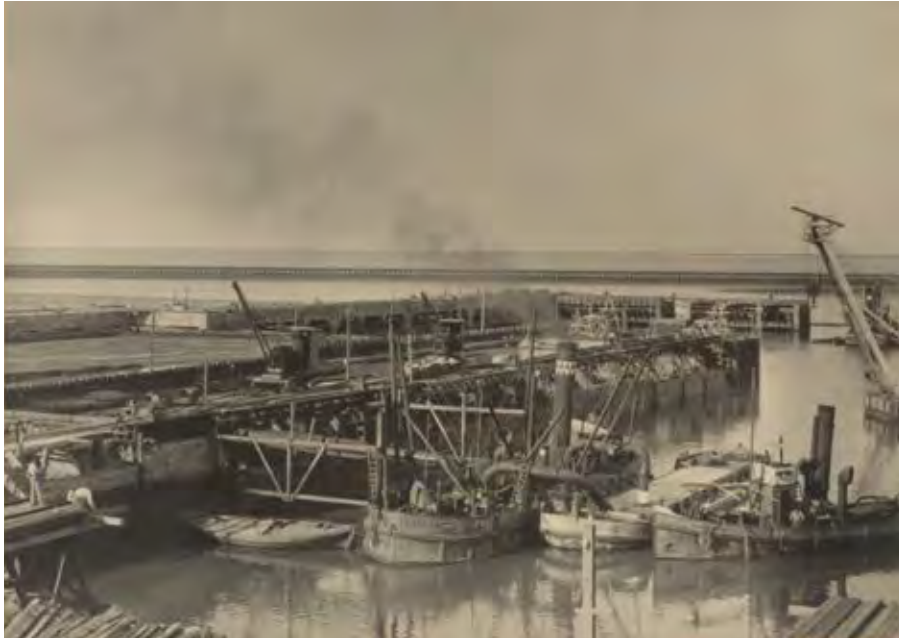
De bakkenzuiger Schelde I wordt ingezet voor baggerwerken en terreinverhogingen in de militaire haven van Bahia Blanca, Puerto Belgrano, 1908-1911.
