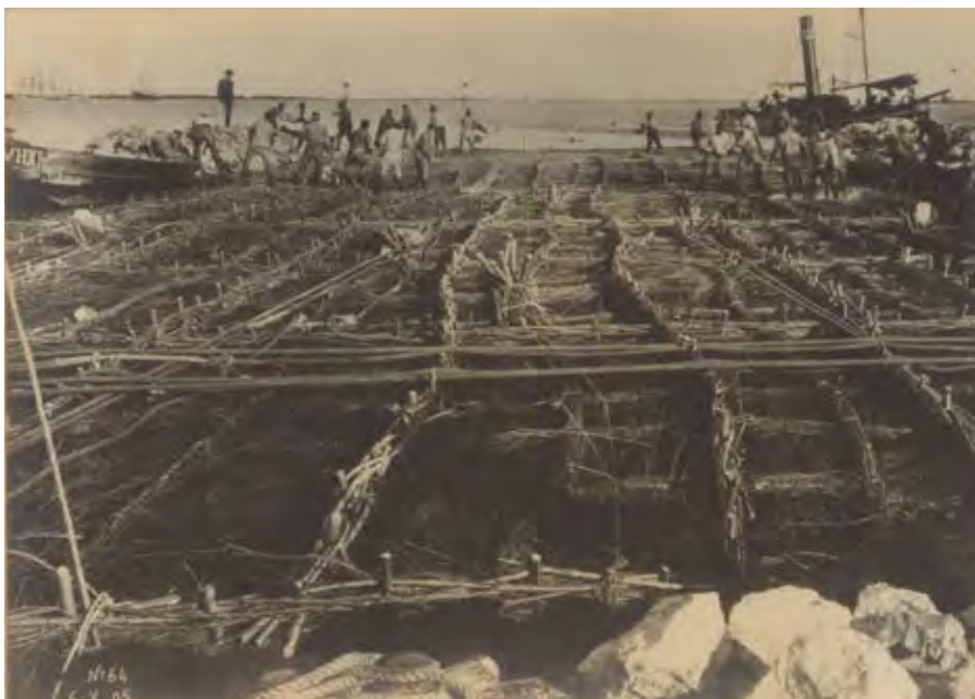
Het bouwen van zinkstukken aan de Quebradadijk in Rosario (1904-1918).
