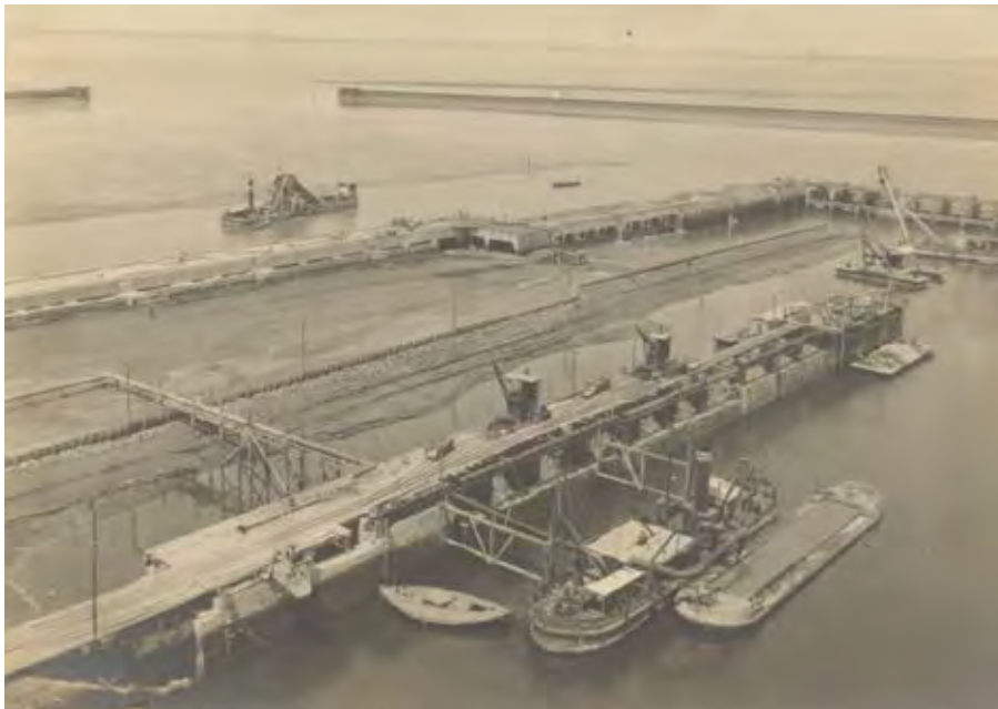
De emmerbaggermolen Antwerpen en de bakkenzuiger Schelde I bij de bouw van het nieuwe dok in de militaire haven van Bahia Blanca, 1908-1911.
