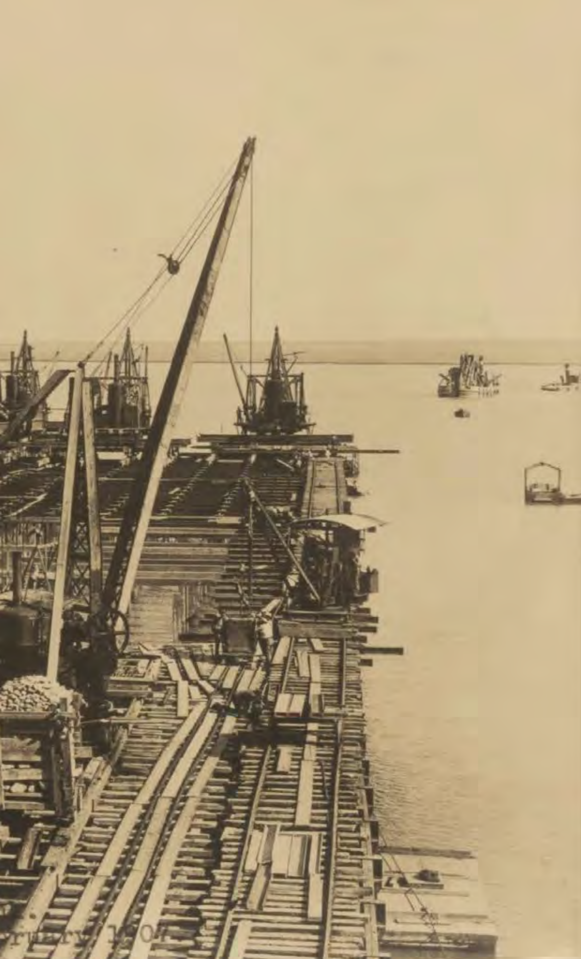
De emmerbaggermolen Antwerpen en de sleepboot Marguerite voeren bagger- werken uit voor de Argentijnse onderneming Ferrocarril del Sud in de goederenhaven van Bahia Blanca, Ingeniero White, met het oog op de bouw van een havendok in de spoorweg- haven tussen 1906 en 1908.
