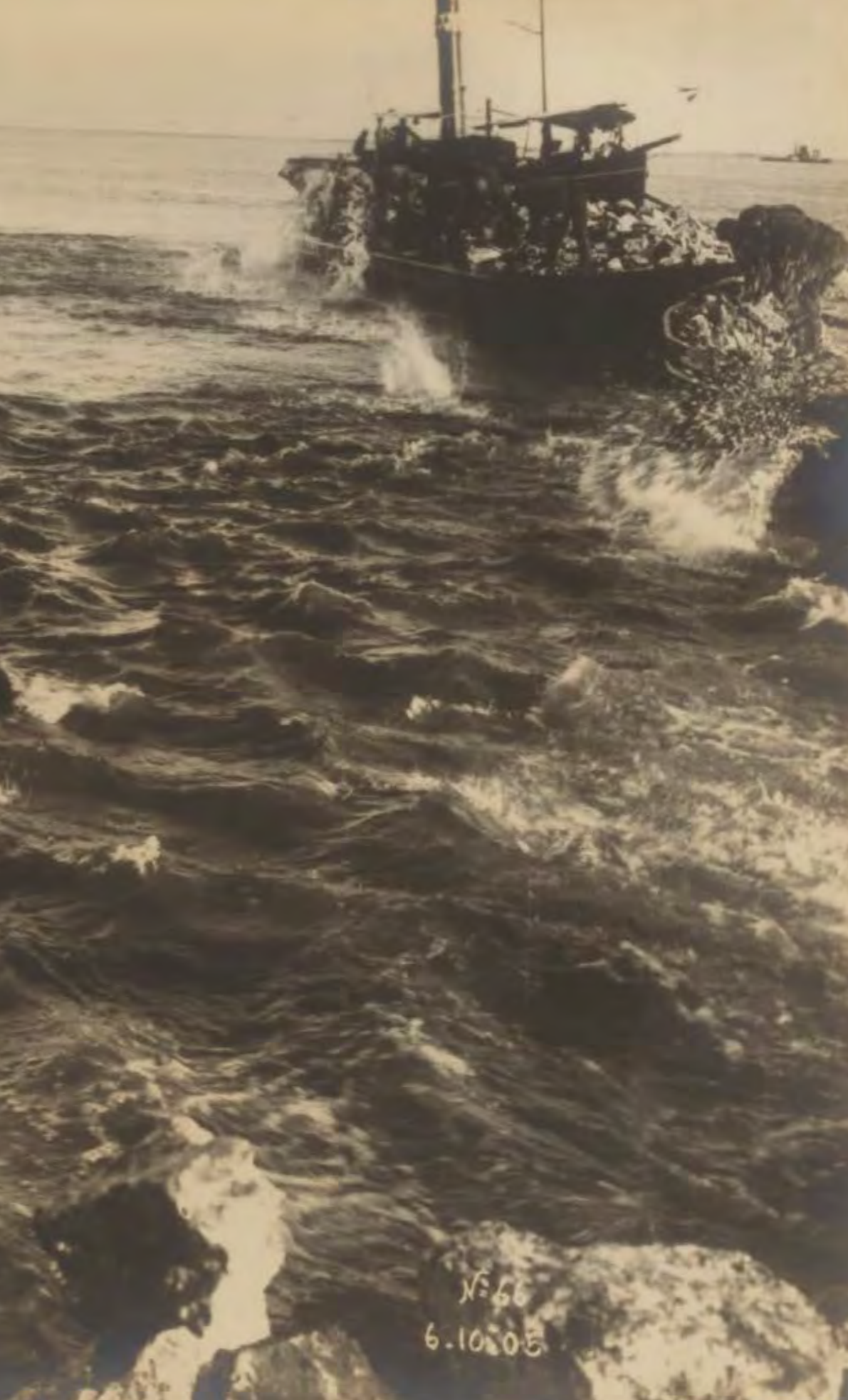
In en voor de haven van Buenos Aires werden er verschillende zinkwerken uitgevoerd (1904-1905-1912) goed voor een totale oppervlakte van 15.000m 2 .
