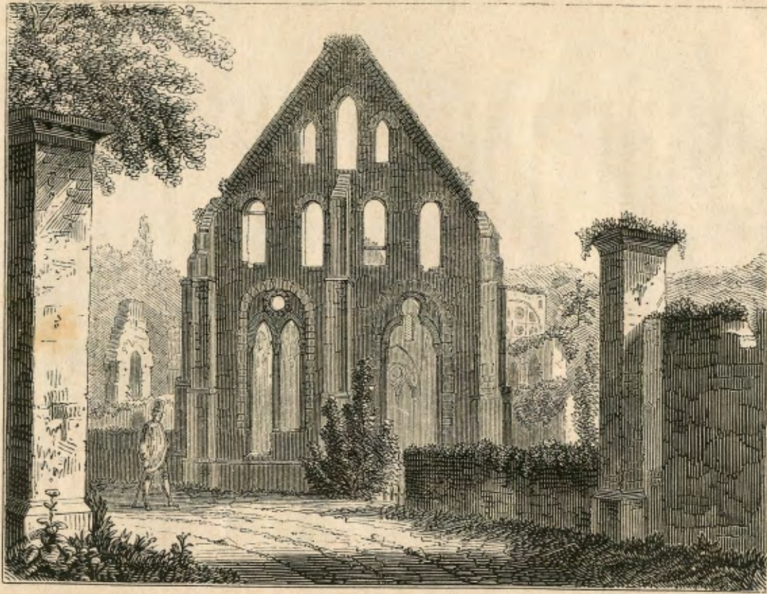
LE RÉFECTOIRE (PIGNON MÉRIDIONAL).
