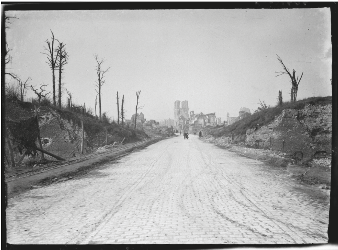
Antony d'Ypres gebruikt het perspectief van de schuinaflopende wand van de vestingsmuur bij de Menenpoort voor een verre desolate blik op het belfort . Ieper, 4-4-1919
